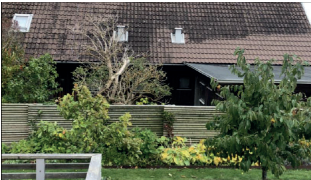
Figur 2 Bild på befintlig fastighet med sadeltak på Skallen
