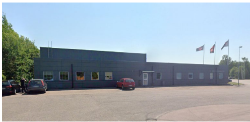
Befintlig byggnation vid Skallebackavägen.
