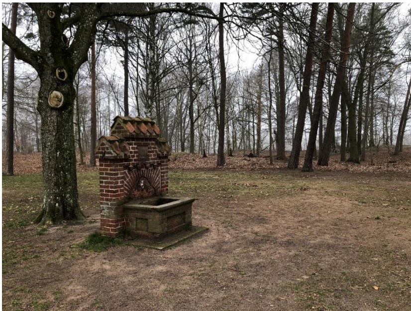
Figur 8. Mönstermurad tegelfontän med enkupiga tegelpannor.
