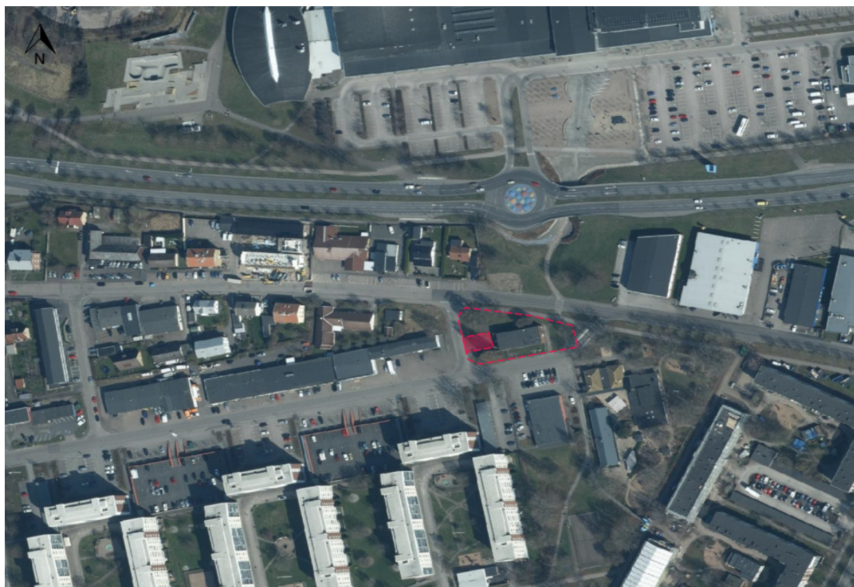
Flygbild, röd linje fastighet Hetären 1 och röd markering platsen för transformatorstation.
