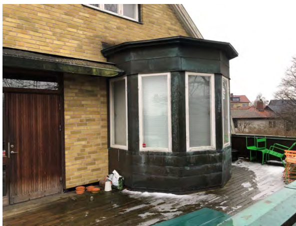
Burspråk på tillbyggnadens takterrass.
