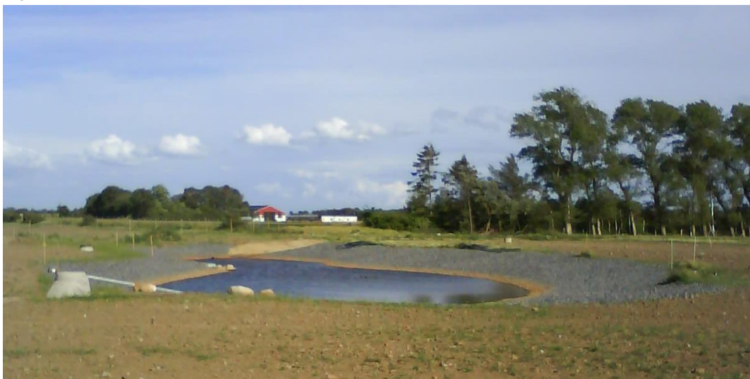
Figur 13. Exempel från Helsingborg på damm med en permanent vattenspegel. Källa: Sweco.
