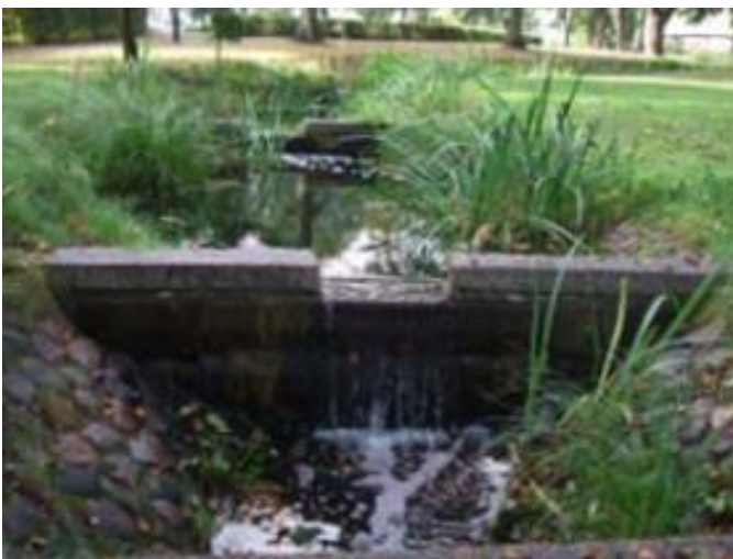
Figur 19 Svackdike med dämmande sektioner. Foto: Veg Tech.
