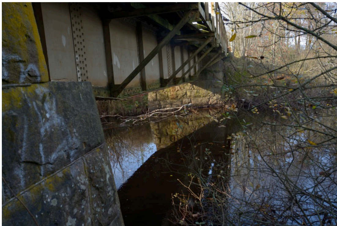
Figur 8. Brofästena på gamla järnvägsbron.
