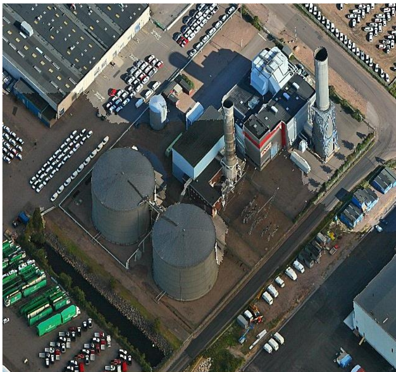
Figur 5: Uniper:s spetsanläggning i Halmstad.
