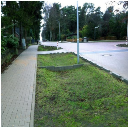
Figur 5. Exempel på utformning av svackdike med dämme för ökad fördröjning och rening av dagvatten. [5]
