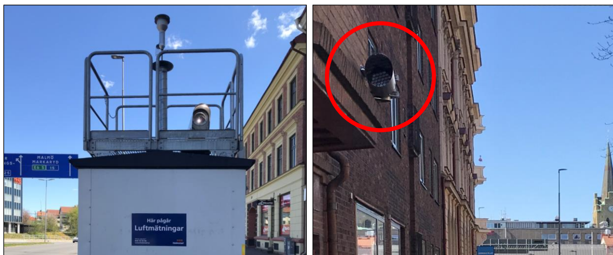
Figur 3.2 a-b. Mätutrustningen vid Viktoriagatan. Vänster bild: mäthuset med insug för partikelmätaren (högst upp mitt i bilden) och kombinerad ljussändare och -mottagare (till höger på takplattformen). Höger bild: Ljusreflektorn.
