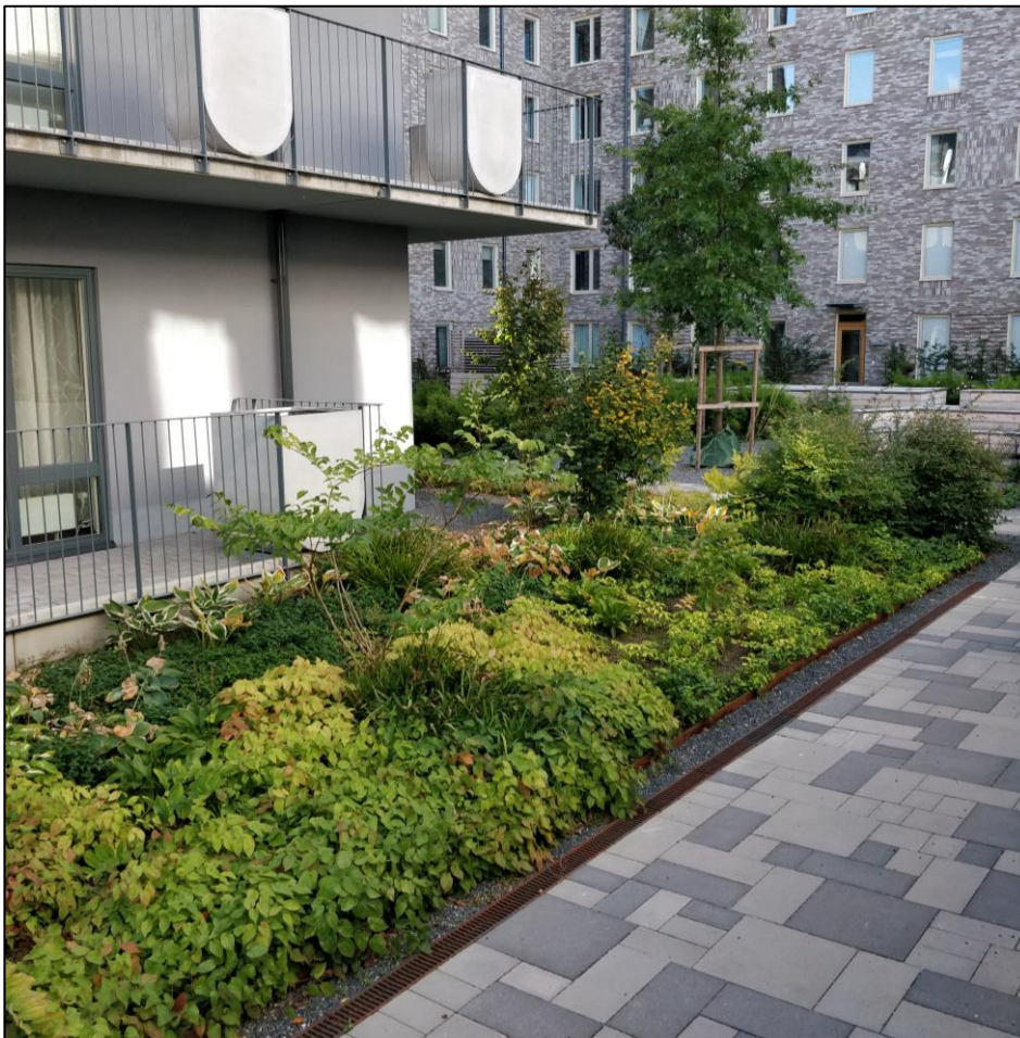
Figur 9. Nedsänkt växtbädd (Bild: Sweco, 2019).
