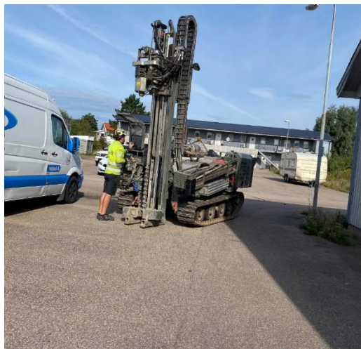
Figur 3. Del av undersökningsområdet fotograferat från öst, vy åt väster.
